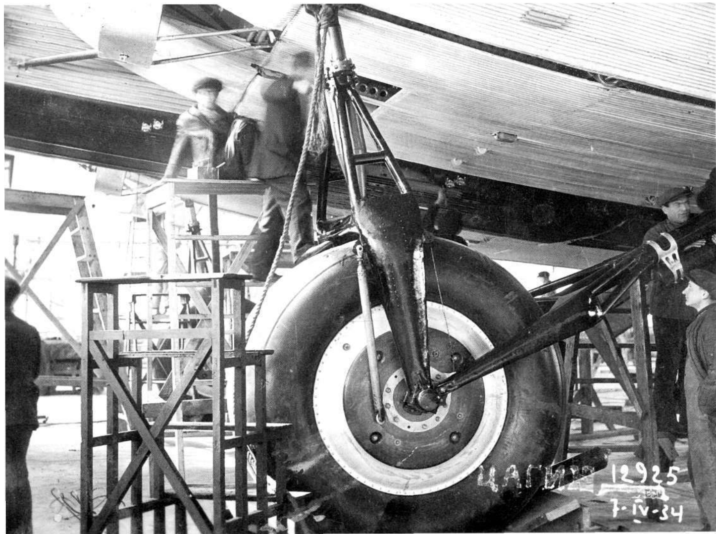
Установка ног шасси
